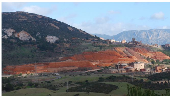
Figura 3. Discarica dei “fanghi rossi” (sterili dell'impianto di elettrolisi), Monteponi, Iglesias. Vista dalla miniera di San Giovanni, direzione nord-ovest. Al centro della foto è visibile anche la discarica del forno Weltz e il piano inclinato. Sotto i fanghi rossi, a destra è visibile l'impianto di produzione dell'acido solforico e di lavorazione dell'ossido di zinco. Al centro verso destra sono visibili l'impianto di elettrolisi, impianti estrattivi, la direzione (Palazzo Bellavista) ed edifici civili della frazione mineraria. Foto dell'autore, 4 gennaio 2014.
